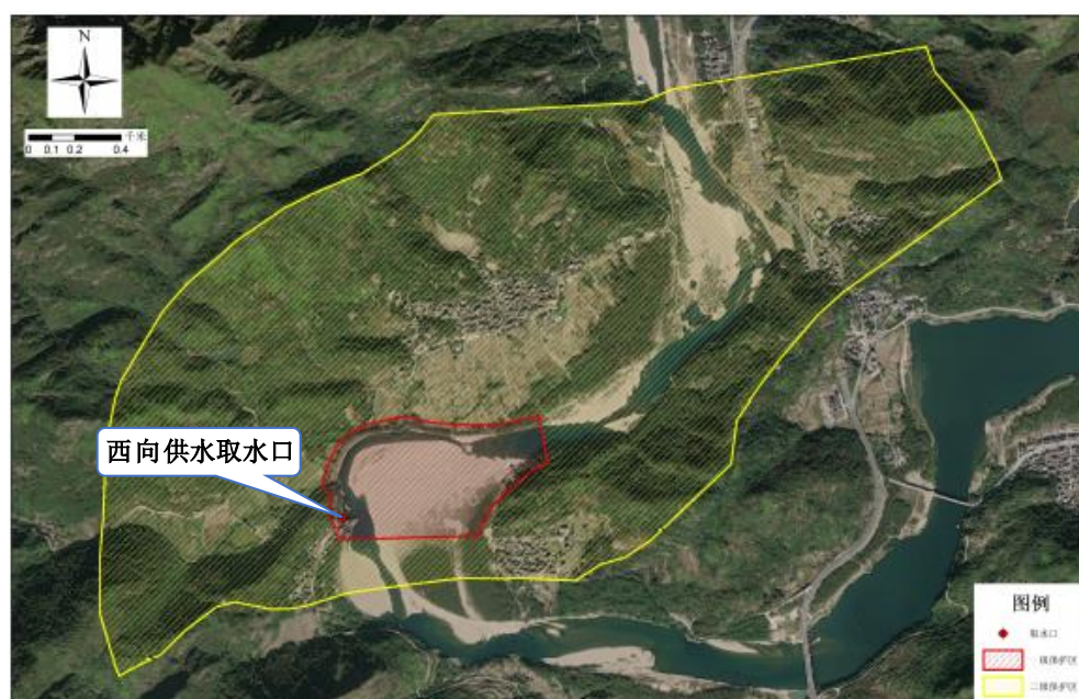
楠溪江东向供水工程饮用水水源保护区（引水工程原取水口）
