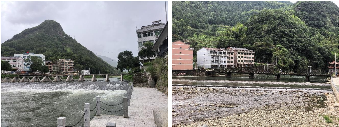
图 3.3-5 楠溪江流域部分堰坝
