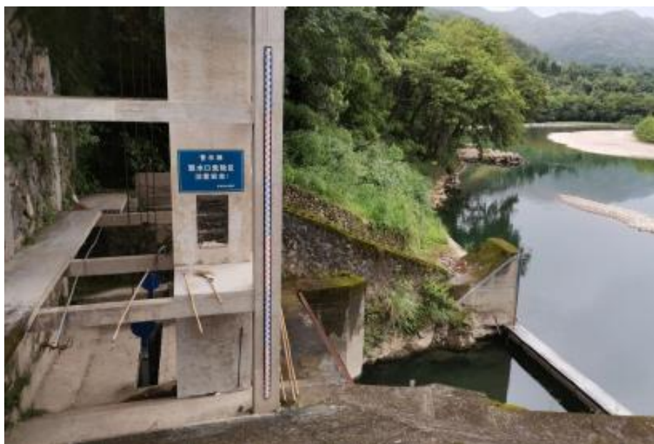
图 3.3-3 楠溪江引水工程（西向供水）取水口
